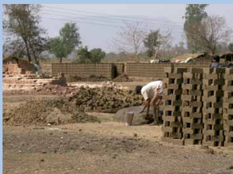
Ouvrier fabriquant des briques à partir de boue
